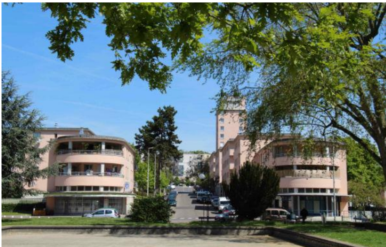
Ill. 1. Rue Albert Thomas avec la Tour Signal (1 er tranche 1931-1933), mai 2014, Barbara Gutglas
