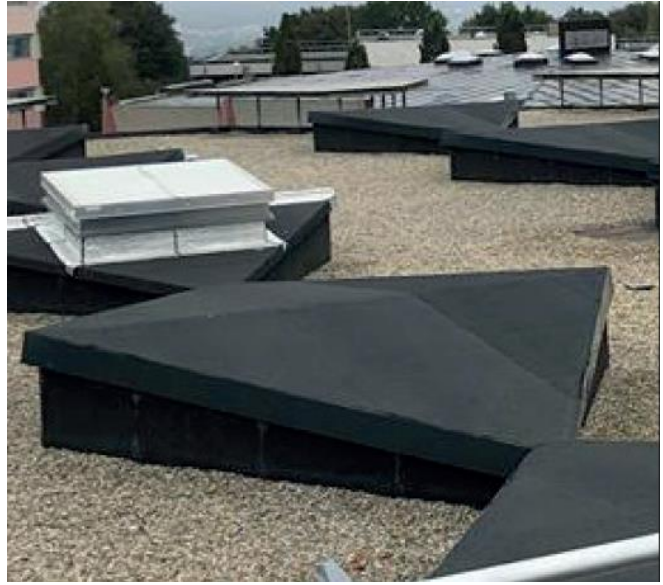
Photo 8 : Lanterneaux en terrasse (aujourd'hui obturés) Photo : ENSA Normandie
