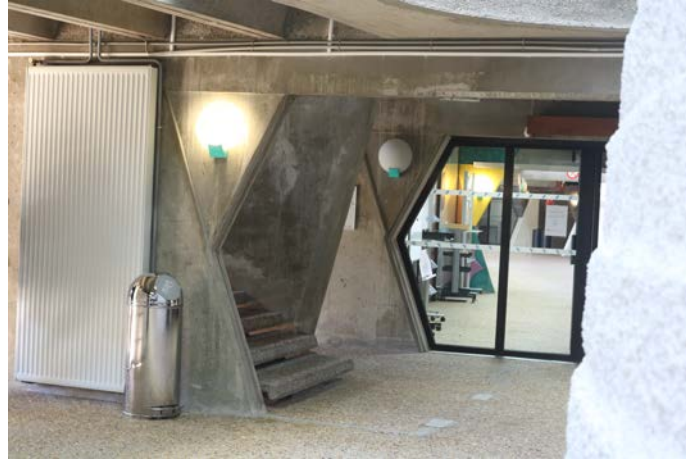
Fig. 5 : porte coupe-feu adaptée à la morphologie du mur de refend
