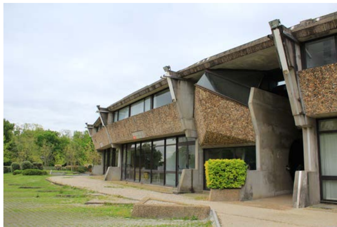
Fig. 6 : figures géométriques qui rythment la façade
