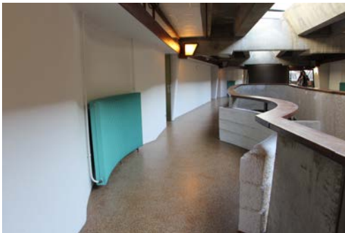
De gauche à droite : Fig. 3, radiateur suivant la courbe du mur et répondant à l'ondulation du garde-corps ; Fig. 4, cheminée du foyer au centre, réfectoire à gauche
