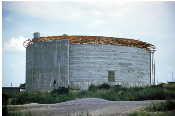
12. 13. Le chantier de construction de la nef. La structure métallique est composée de seulement 4 points d'appuis ; les murs en béton sont dénués de fonction porteuse, excepté aux extrémités.
