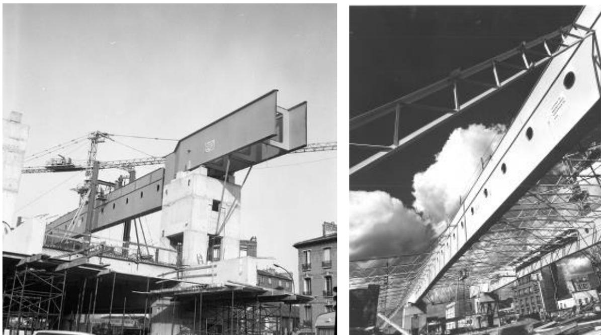
6. Fixation de la poutre centrale (à gauche) et mise en place de la charpente métallique (à droite).
