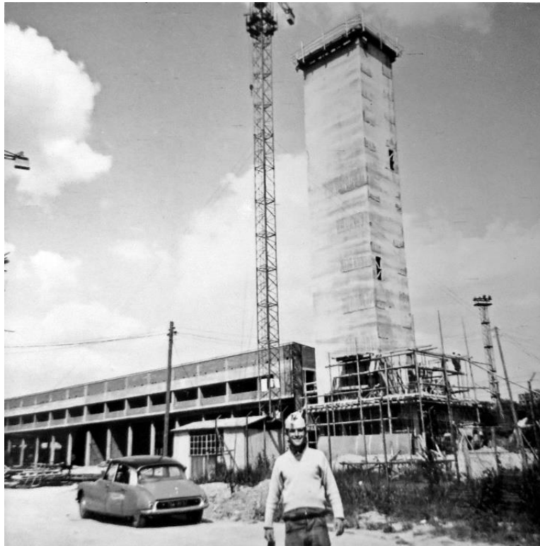
Chantier du bâtiment technique, sans date. Fonds Pingusson, SIAF/Cité de l'architecture et du patrimoine/Archives d'architecture du XX e siècle.
