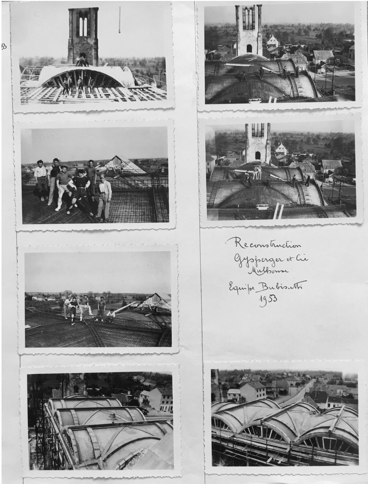
III. 18 : Photographies du chantier de la toiture voûtée réalisée en béton armé par l'entreprise mulhousienne Gysperger, auteur inconnu, 1953, Archives privées de la Société d'Histoire de Sausheim.
