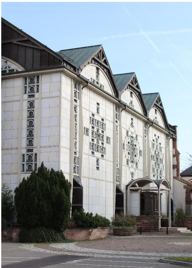
III. 32 : Photographie de la nef contemporaine en béton armé, Noémie Risser, le 28 octobre 2022.
