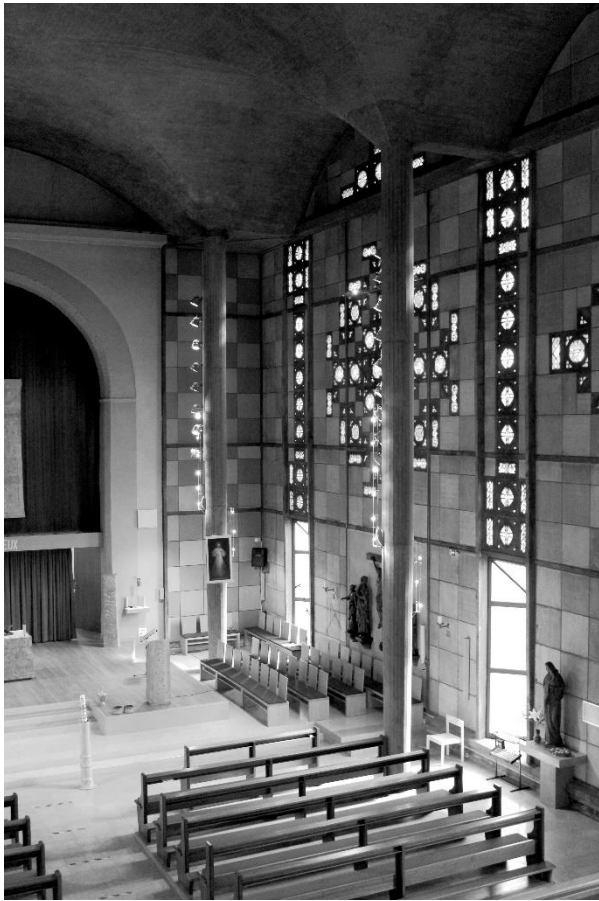
III. 34 : Photographie d'intérieur de la nef contemporaine en béton armé, Noémie Risser, le 16 mars 2023.
