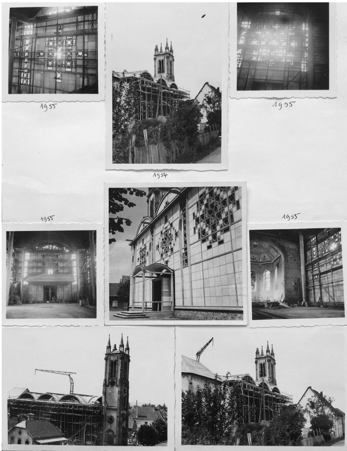
III. 19 : Photographies d'avancement du chantier de la nef et installation des vitraux et de la tribune de l'orgue, auteur inconnu, 1954 – 1955, Archives privées de la Société d'Histoire de Sausheim.
