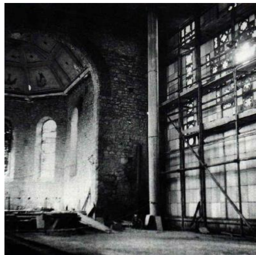
III. 16 : Photographie de l'avancement des travaux des murs et vitraux de la nef, Pierre Collin, 1953, Archives privées de la Société d'Histoire de Sausheim.
