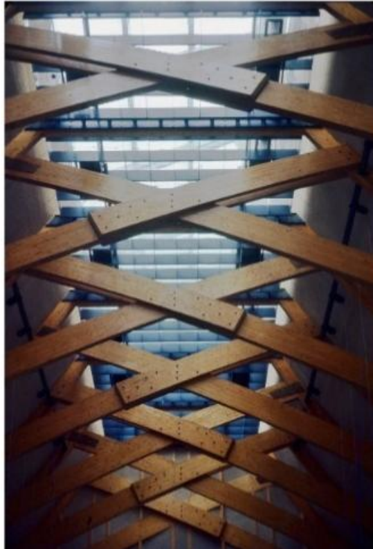
18- Détail de la charpente de la salle des cérémonies avec son éclairage zénithal. Photo : MP Auzelle, mars 1973, Fonds Robert AUZELLE, Ifa 242.
