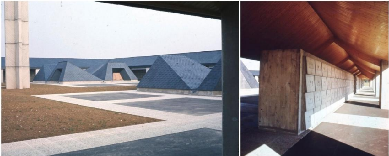
23- Vue des fosses collectives et du signal de l'ossuaire (gauche) et vue des portiques de l'ossuaire (droite). Photo : MP Auzelle, avril 1974. Fonds Robert AUZELLE, Ifa 242.
