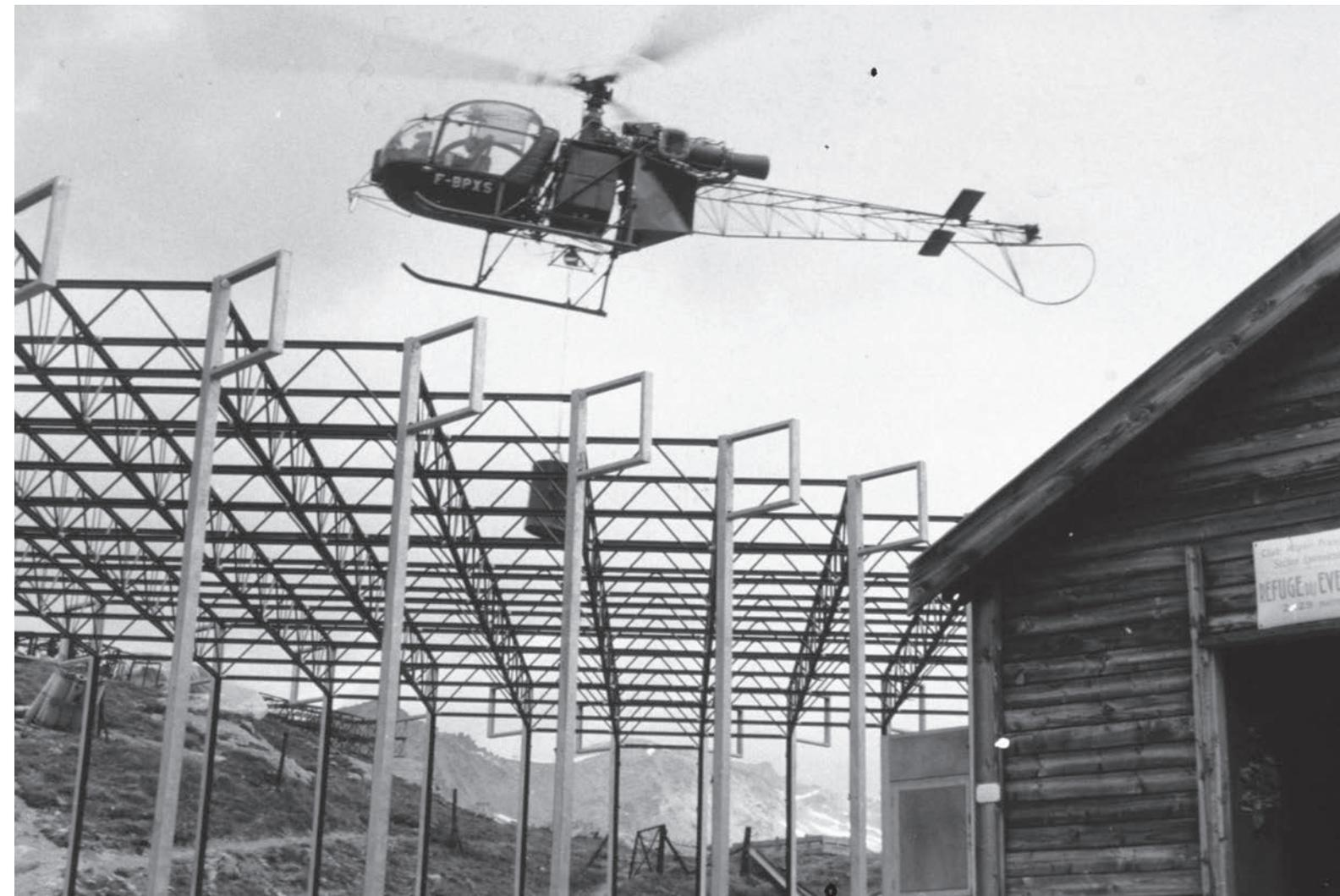
7- Charpente aluminium en cours d'assemblage sur le chantier du refuge des Évettes
