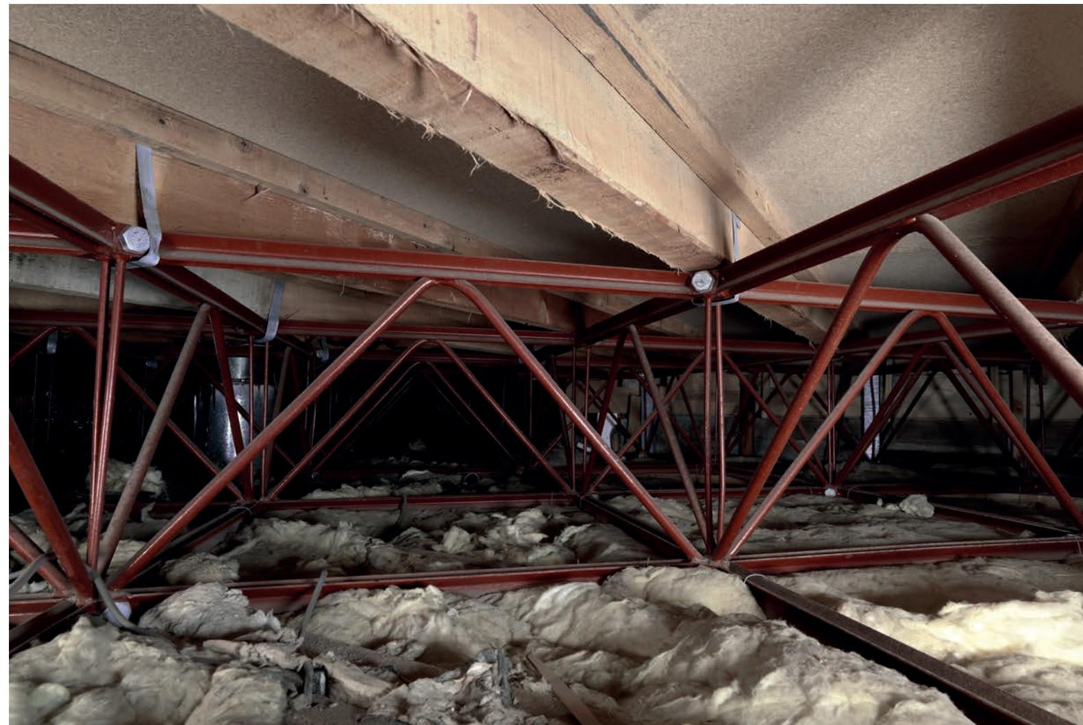
9- Charpente aluminium composée de modules tridimensionnels assemblés à chaque angle, couverte par une toiture porte-neige.
