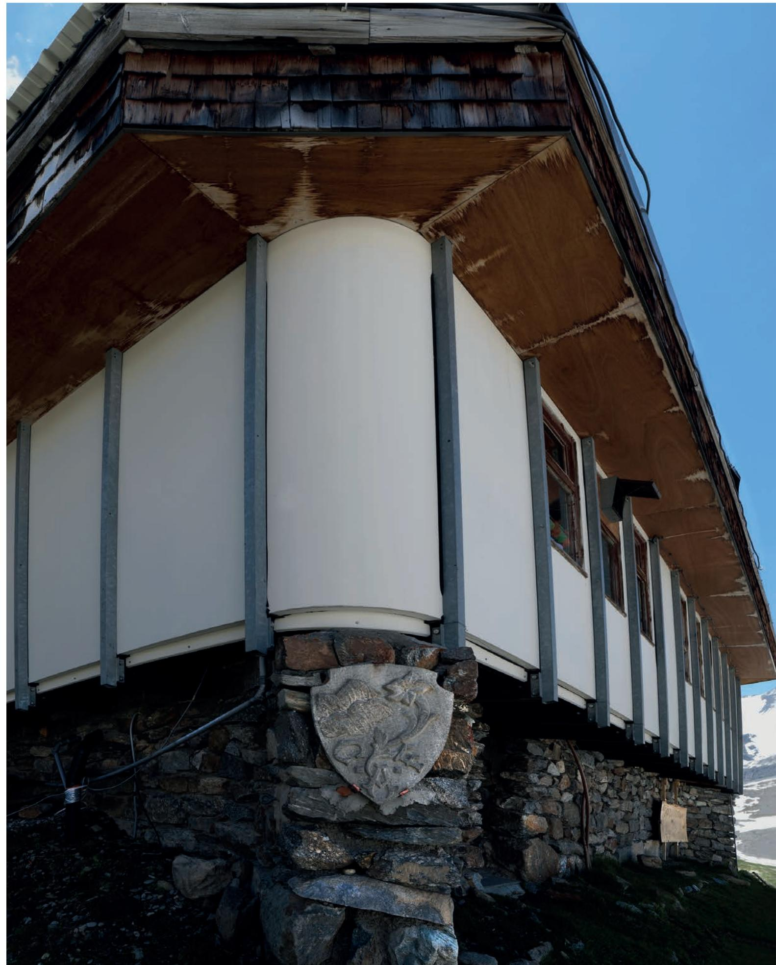
11- Façade : soubassement en maçonnerie de béton et pierres surmonté de la charpente en aluminium sur laquelle sont fixés les panneaux « Matra ».
