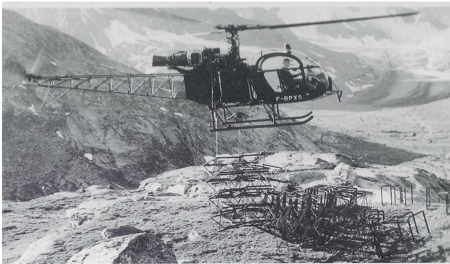
6- Acheminement par hélicoptère des modules tridimensionnels sur le chantier.
