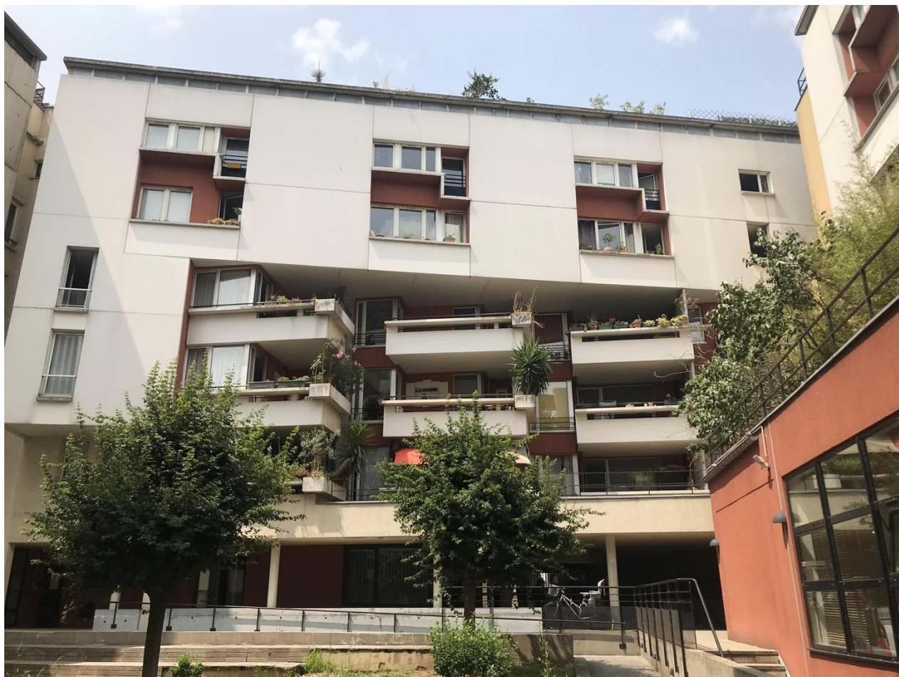
Fig. 1 Façade sur cour, mai 2023 © José Piquer
