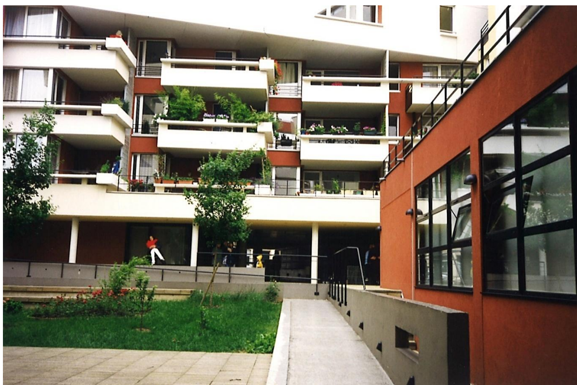
Fig. 16 Vue depuis la cour, mai 2023 © José Piquer
