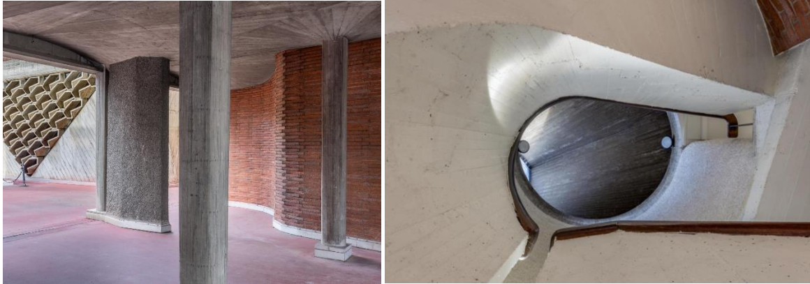
16- 17- Détail des piliers et des éléments préfabriqués à l'extérieur de l'auditorium - Escalier d'honneur, photo : © Vincent Boutin, 2019
