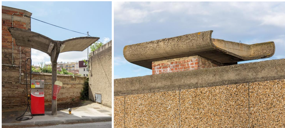
18- 19- Station-service, photo : © Raphaëlle Saint-Pierre, 2017 ; Détail des cheminées, photo : © Vincent Boutin, 2019
