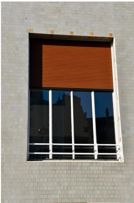
Placés au-dessus des baies des studios, à hauteur des planchers de l'étage supérieur, des cabochons en grès ocre rappellent la présence de la poutre et rompent la monochromie du gris du nu de la façade.
