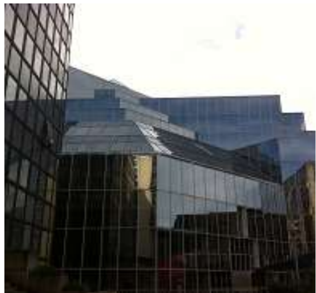
Bibliothèque 016 détails côté dalle Photo Sauvegarder Mériadeck
