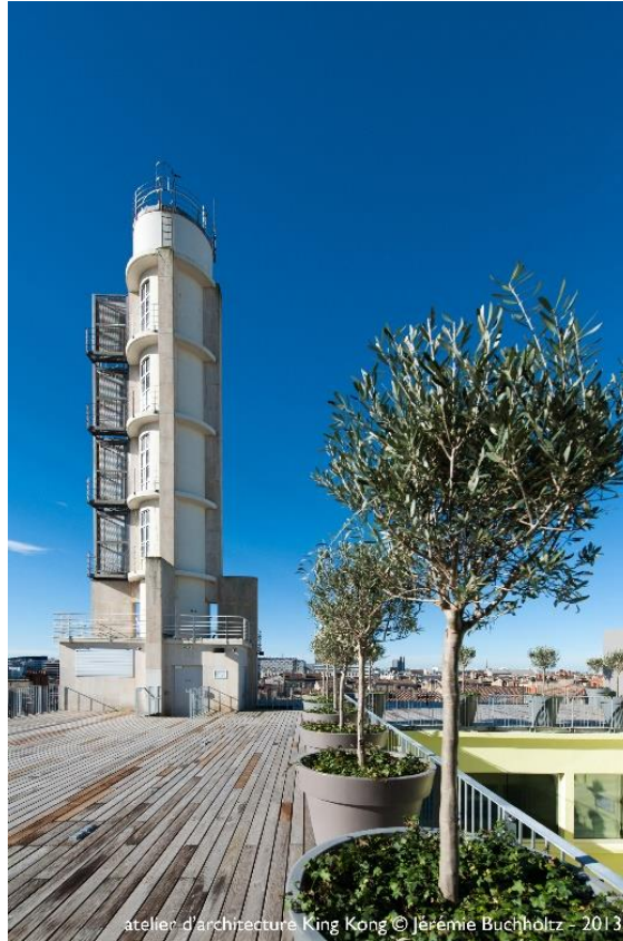
Figure 8 - La toiture terrasse et la tour / Crédit photo : atelier d'architecture King Kong, Jérémie Buchholtz, 2013
