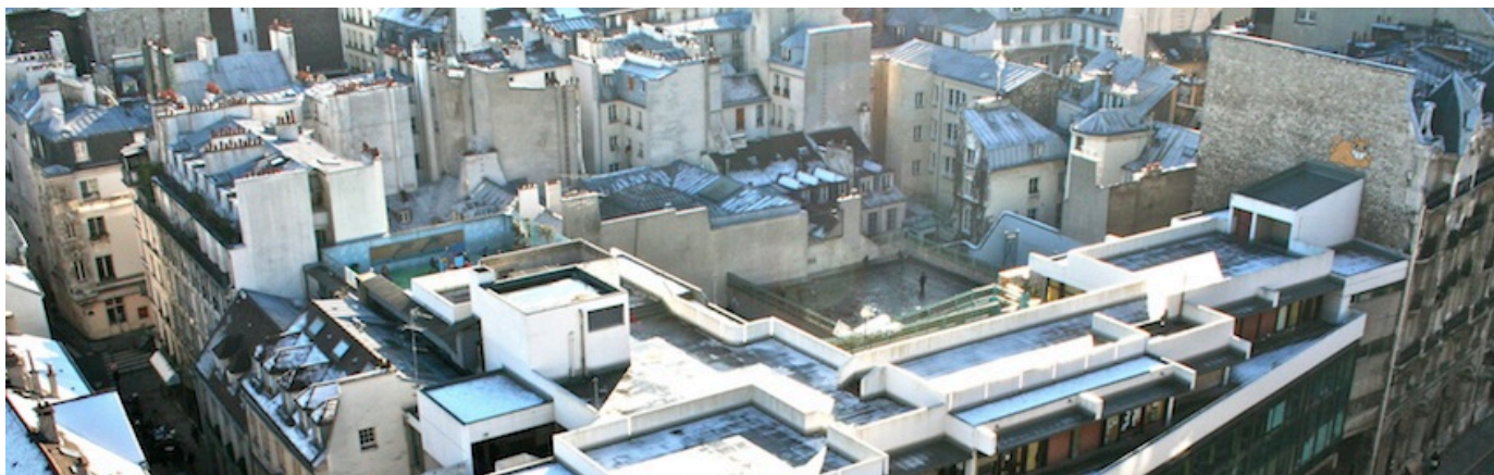
Vue aérienne (détail) de l'École Saint-Merri, prise du Centre G. Pompidou, 2009 © O. Nouyrit, all rights reserved
