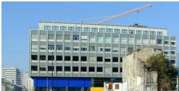
La poste 008 : la construction
