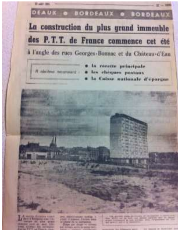
La Poste 007, emplacement prévu pour la construction
