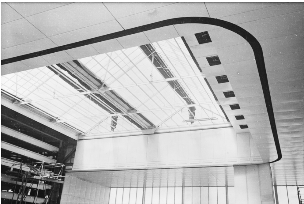
III. 12. Vue sur la verrière permettant un éclairage maximal de l'espace intérieur, vers 1939. Centre Pompidou, Mnam-CCI, Bibliothèque Kandinsky, Fonds Jean Prouvé, D.R.
