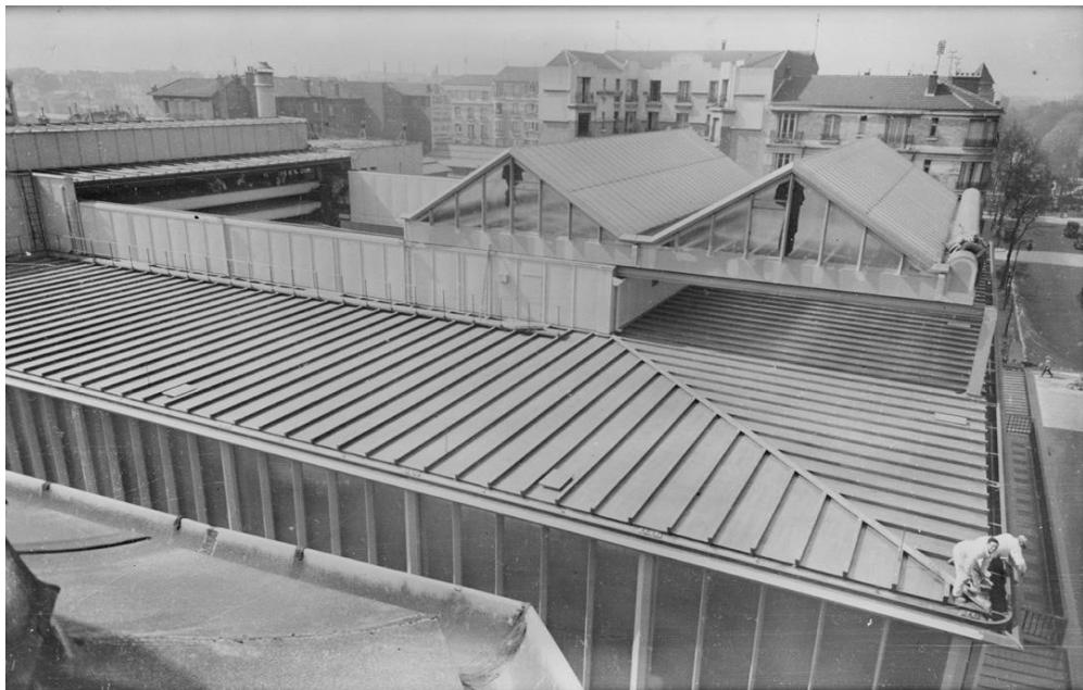
III. 11. Comble roulant ouvert, 1939. Centre Pompidou, Mnam-CCI, Bibliothèque Kandinsky, Fonds Jean Prouvé, D.R.
