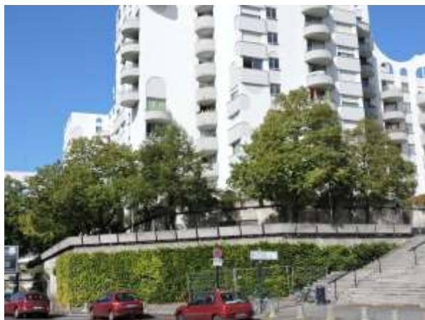
Les jardins 020 : les demi-terrasses et l'escalier cours Maréchal Juin Photo Sauvegarder Mériadeck
