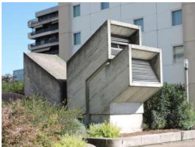
Les jardins 016 : bouches d'aération de parking Photo Sauvegarder Mériadeck
