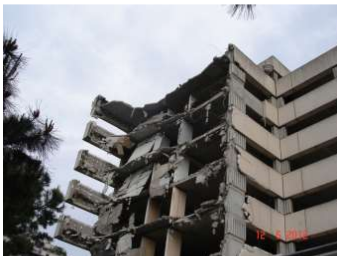
Photo Sauvegarder Mériadeck - Démolition
