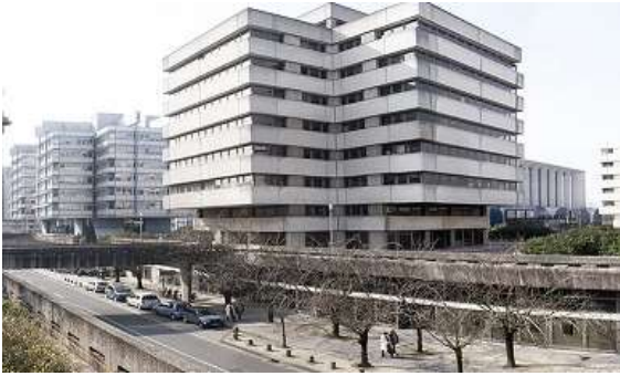
Croix du Palais 001 état d'origine
