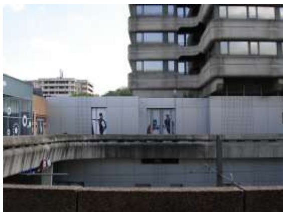
Photo Sauvegarder Mériadeck - Extension du centre sur la dalle
