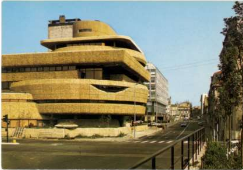
Caisse d'Epargne : état général à la construction
