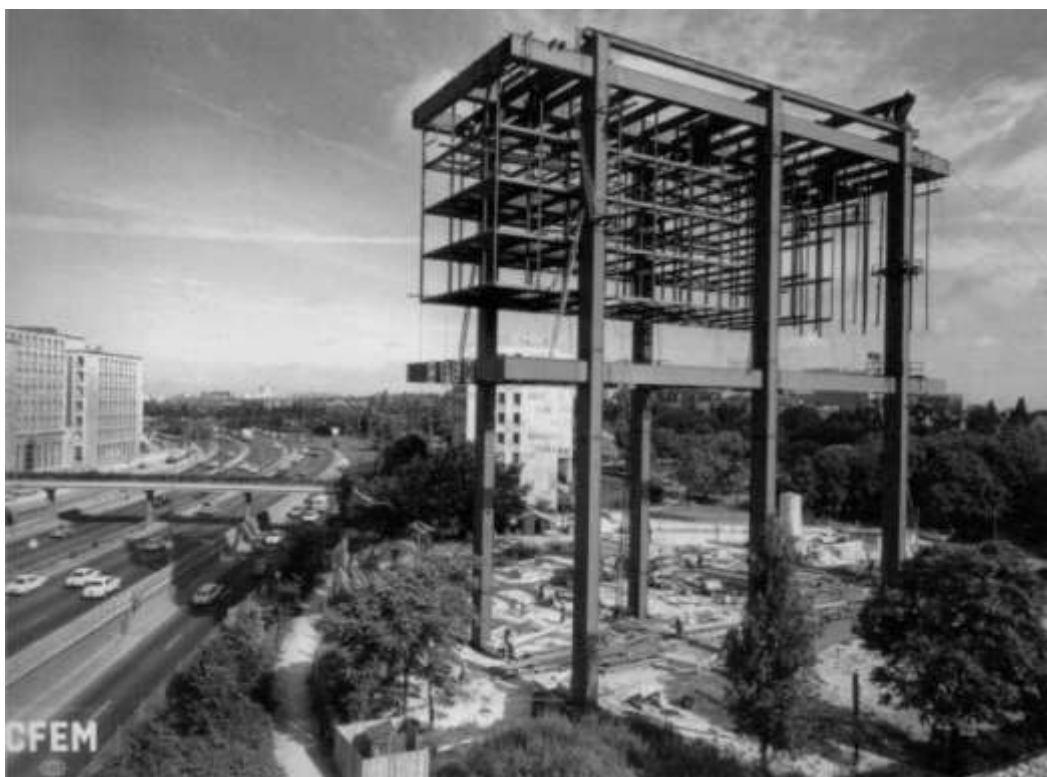
Ill. 4. Maison de l'Iran. Montage de l'ossature métallique, 1967 (© Cité internationale universitaire de Paris / Photo CFEM / DR /27 juin 1967).
